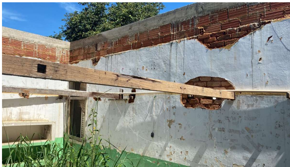
SALA 03 - PAREDES E JANELA
