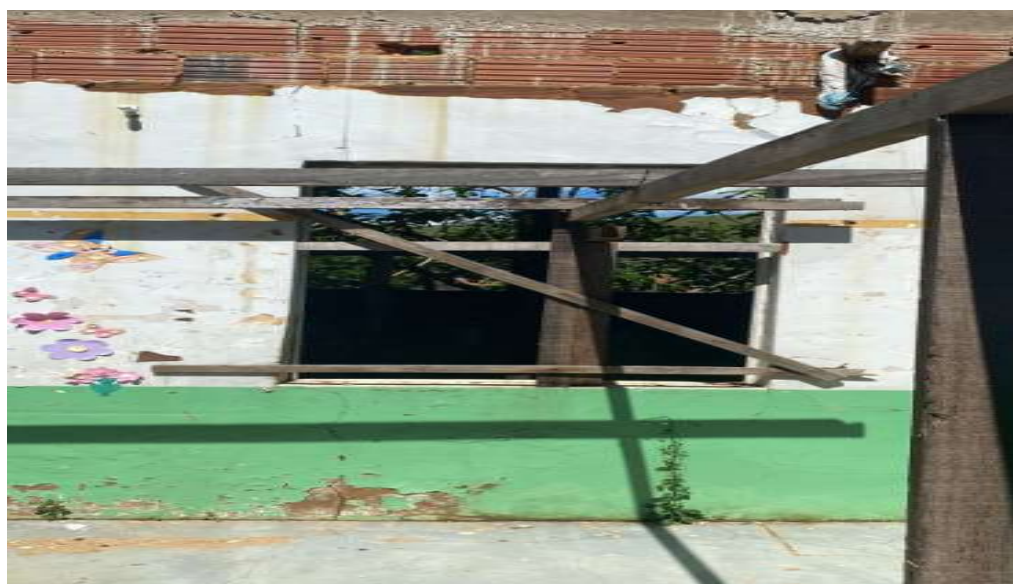
Sala 01 - Parede e janela
