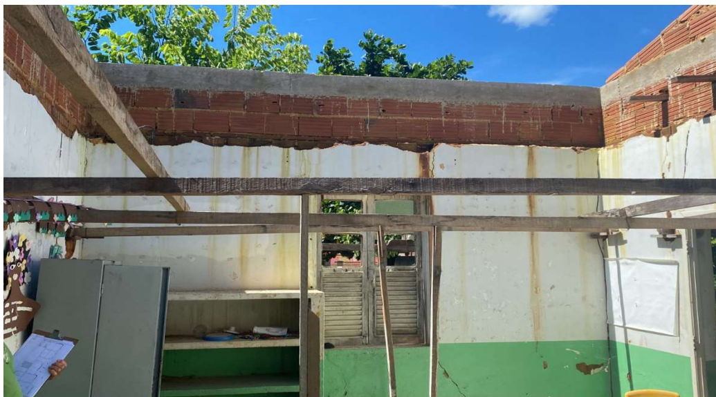
Sala 01 - Paredes internas
